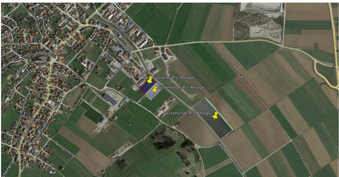
Bild 2.1.1: Luftbild der PV-Anlage (Quelle: Google Earth / SolPEG)
