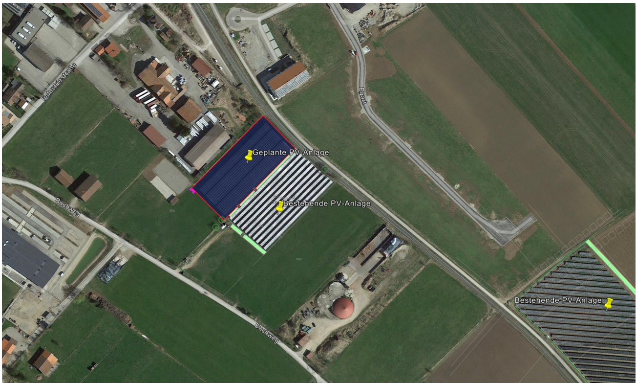
Bild 2.1.2: Luftbild der PV-Anlage (Quelle: Google Earth / SolPEG)
